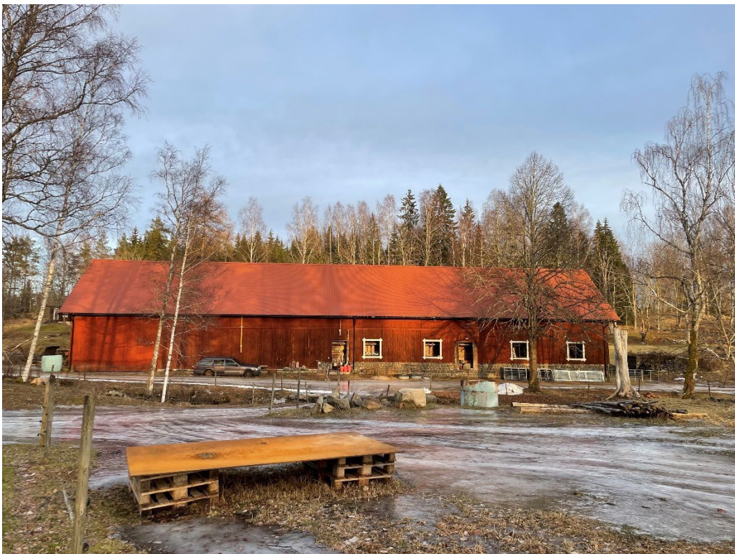
Figur 4. Fårhuset med rött plåttak där Erik skulle vilja sätta solpaneler
