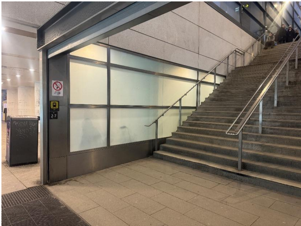
Figur 18. En bild tagen i undergångspassagen som visar på väggarna i frostat glas. Man kan i bilden skimta en svag silhuett av någon som står bakom glasväggen men siktbarheten räcker inte längre än så. För att främja siktbarhet ges ett förslag att ersätta det frostade glaset mot ett mer transparent material. Fotografi: Kajsa Holmgren 2024.
