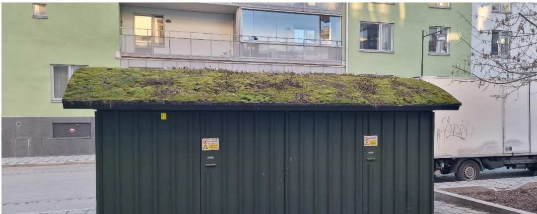
Figur 2: Grönt tak med sedum på Parkvägen, Järfälla. Foto: Saga Rosell 2024.
