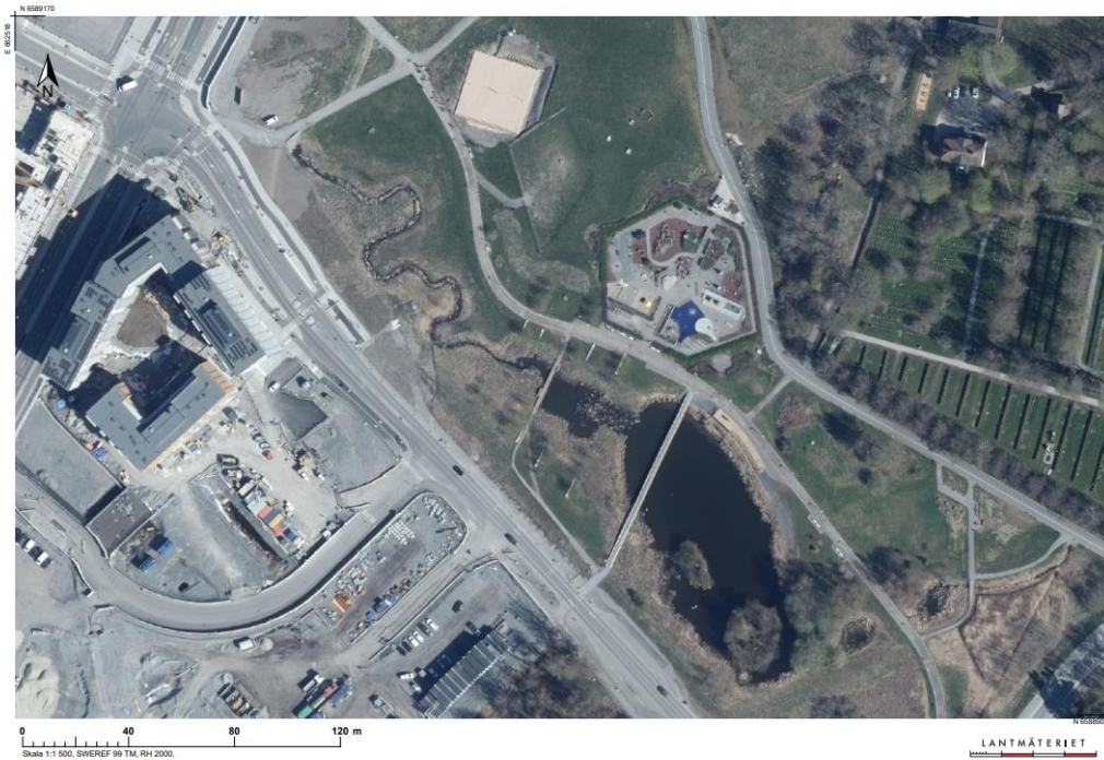
Figur 15: Foto av Kyrkparken och dess dagvatten. Från nordväst syns den meandrande bäcken innan den når dammen. Flygfoto: Järfälla © Lantmäteriet 2024.
