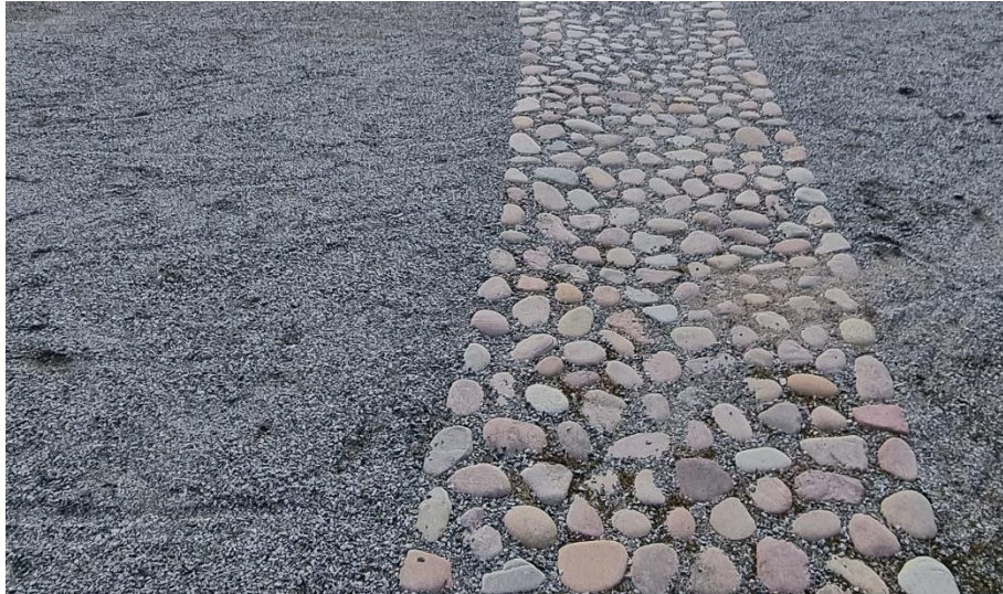
Figur 4: Genomsläpplig beläggning i form av grus och marksten, Järfälla. Foto: Saga Rosell 2022.
