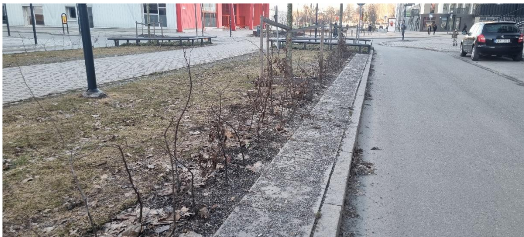
Figur 11: Växtbädd med gräs, häck av avenbok med träd i bakgrunden på Karlslundsvägen. Foto: Saga Rosell 2024.
