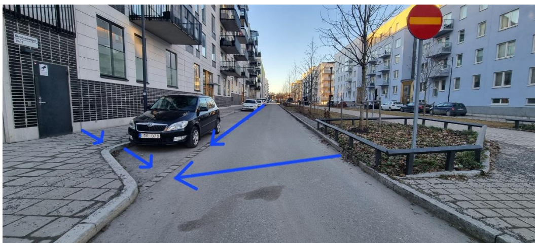
Figur 10: Illustration av vägens lutning och lågpunkt på Karlslundsvägen. Foto och illustration: Saga Rosell 2024.
