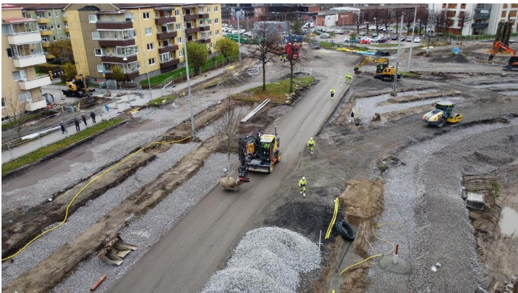
Figur 1. Foto över anläggningsarbete av växtbäddar vid hårdgjord yta (Örjan Stål u.å).
