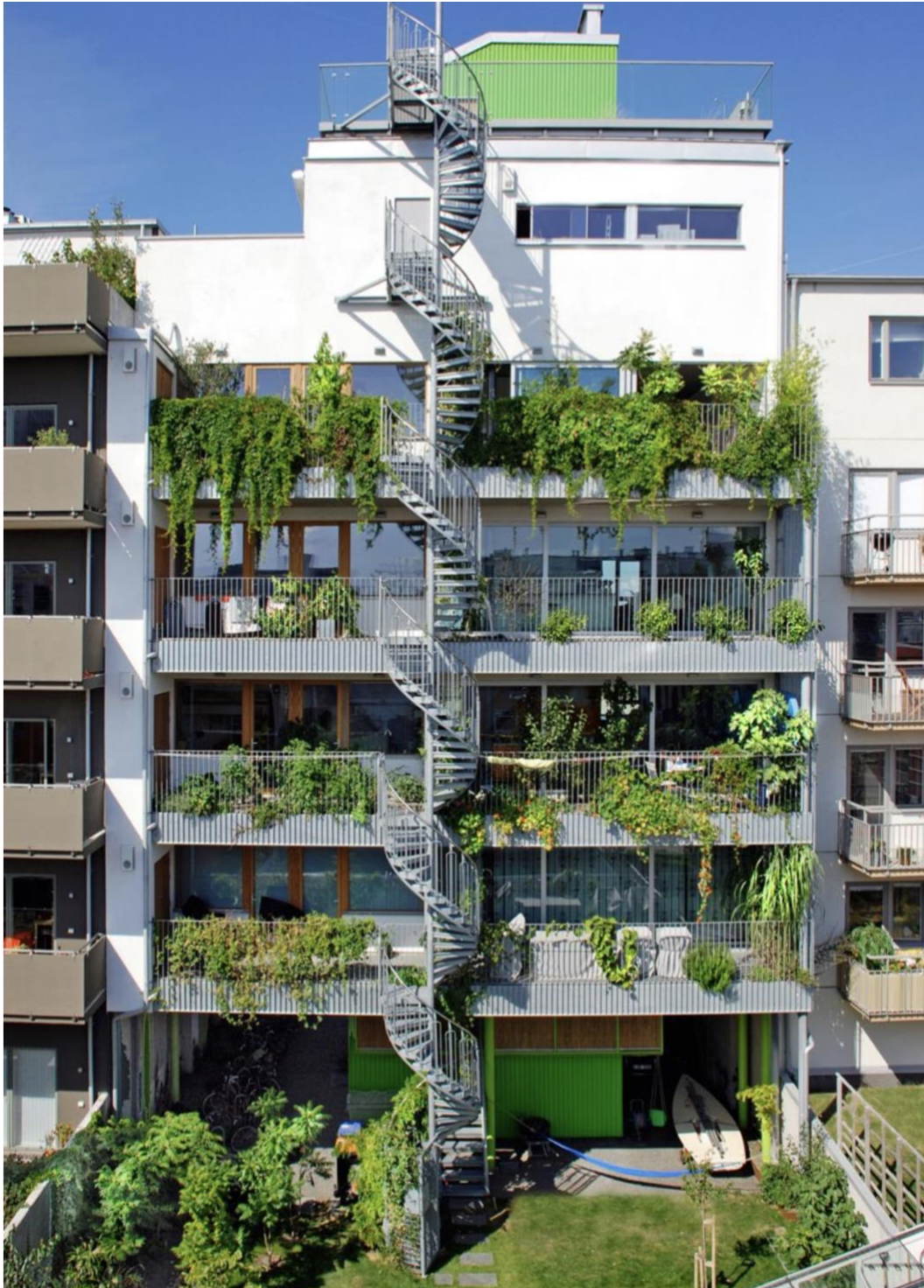
Figur 8. Bostadshus med kraftiga, planteringsbara bjälklag och gemensamma odlingsmöjligheter visar på nya sätt att arbeta i den trånga stadsmiljön (Malmö stad 2018:71).
