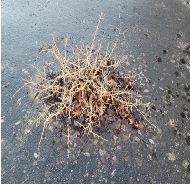
Bild 8. Havtornsbuske som tränger igenom asfalt på Kvarnby upplagsområde (Axel Marnung, 2024).
