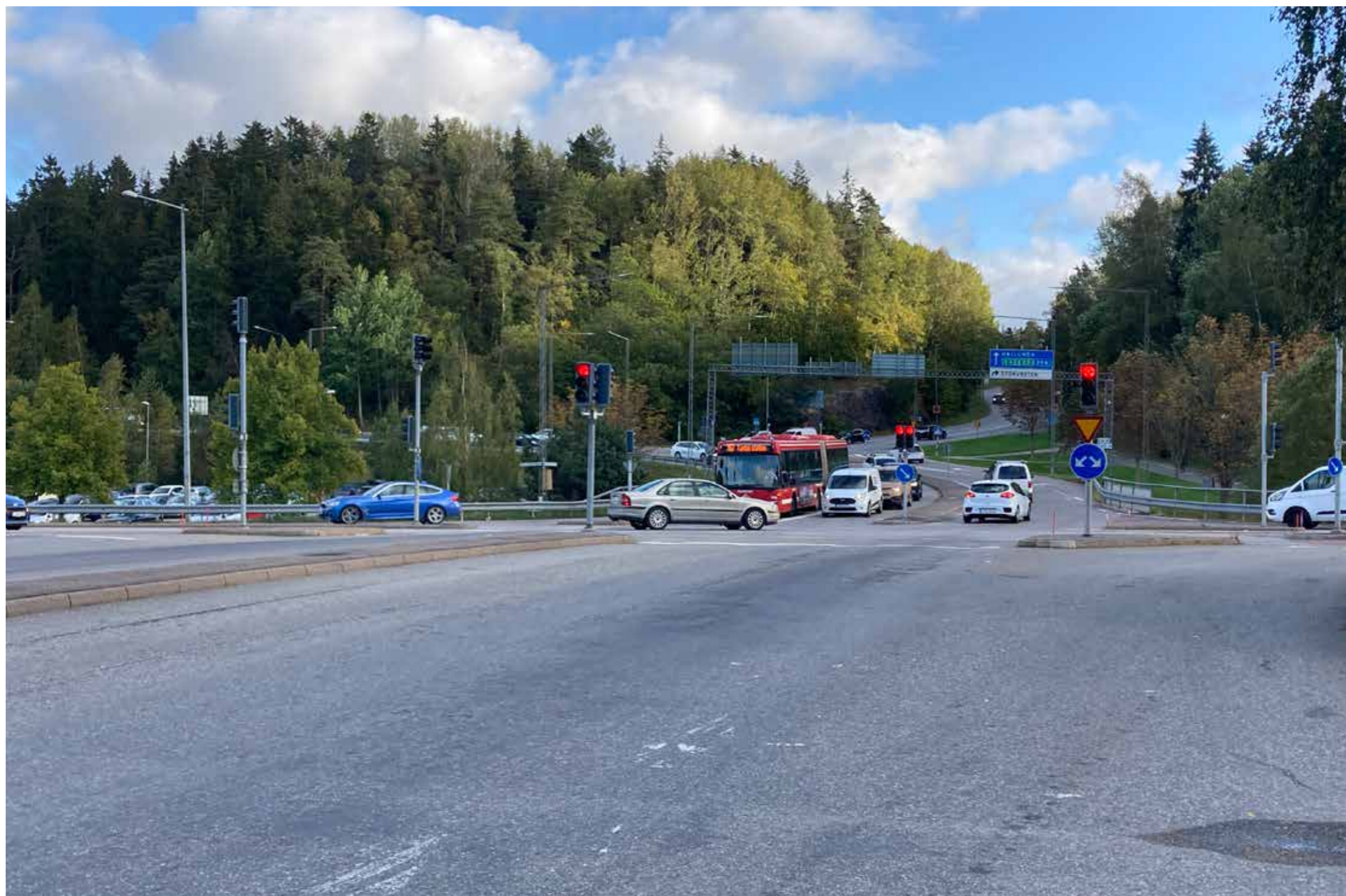
Figur 13. Entré till Storvreten från Tumba centrum. För att ta sig till Storvreten måste gående veta var stadsdelen ligger eftersom den är dold bakom skogen. Den storskaliga trafiklösningen lockar inte till spontana besök. Foto författaren 2023.
