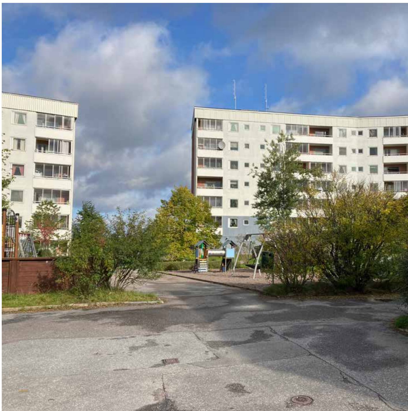
Figur 15. Flerfamiljshusen är enhetligt gestaltade. Även de byggnader som avviker i form följer samma dämpade färgskala. Mellan de storskaliga bostadshusen bildas en storgård, ett stort vardagsrum för samtliga boende. Foto författaren 2023.
