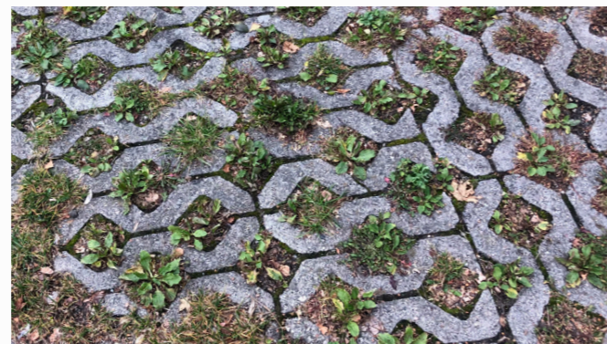
Figur 15. Gräsarmering av betong på parkeringsplats.
