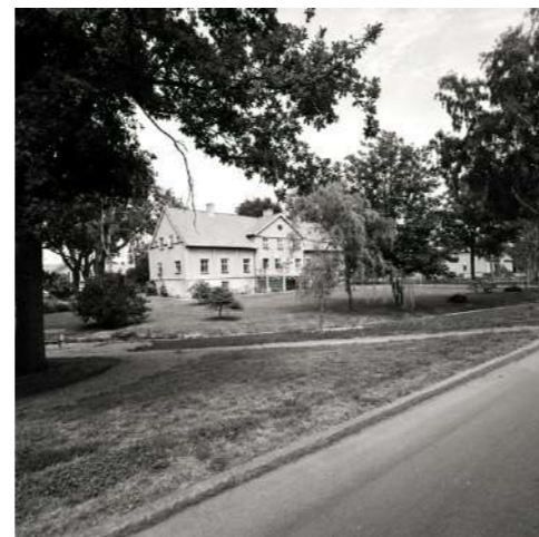
Figur 8. Vy från sydväst över Veterinärrättningen, numera Veterinärmuseum, från 1969.
