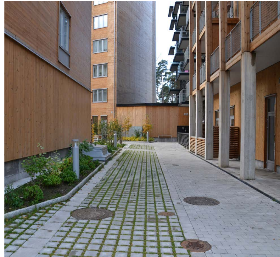
Figur 19. Permeabel markbeläggning med fogar av gräs i Rosendal, Uppsala. Bild hämtad från Fridell et al. (2019) Edge, Levande stadsrum.
