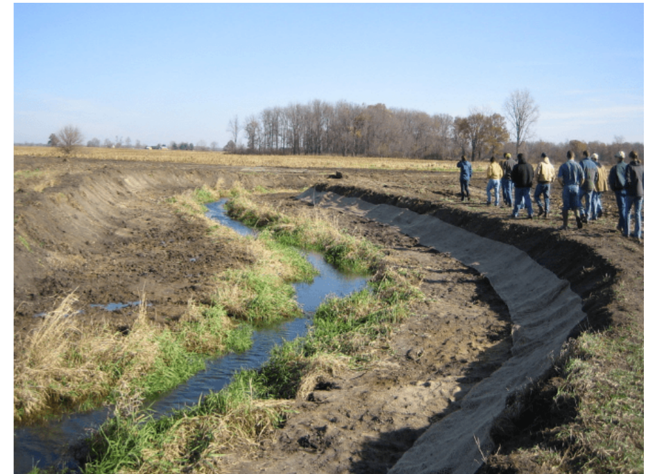
Figur 21. Meandrande tvåstegsdike som nyligen anlagts. Terrasserna och slänterna ökar vattenkapaciteten och gör att dagvatten från kraftiga skyfall kan tas hand om när mittfåran översvämmas. Bild av: Indiana Watershed Initiative, © Wikimedia (2019).
