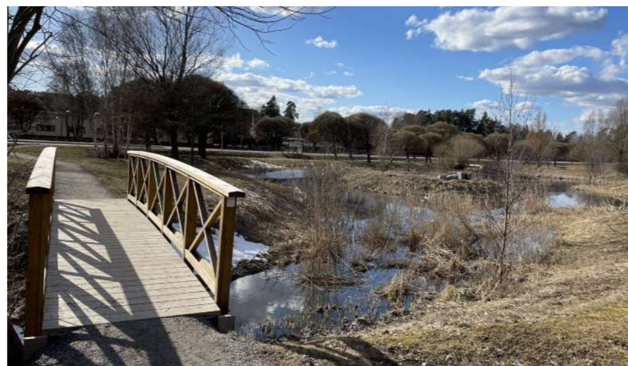
Figur 32. Träbro över ett smalare parti av dammen.
