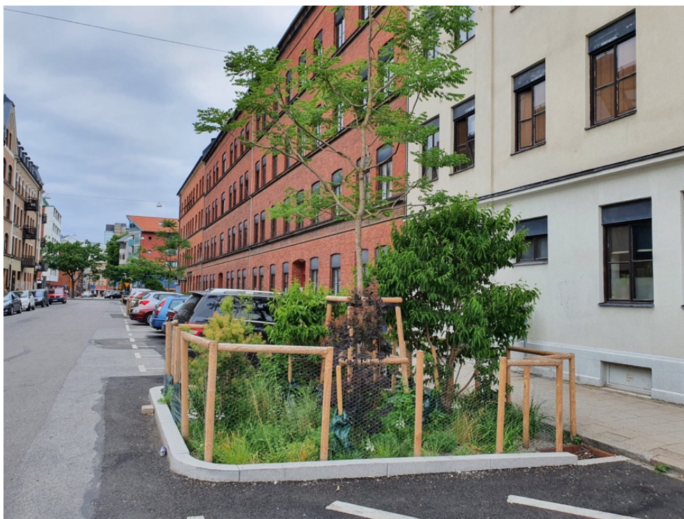
Figur 7. Exempel på kombination av gatuträdplantering och dagvattenhantering. Notera inloppet invid trottoaren. (Östberg u.å.)
