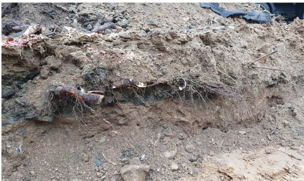
Figur 3. Bilden visar hur ett kompakterat lager gjort att trädrötterna inte trängt ner i djupare markskikt. Rötterna har i stället hållit sig till det övre jordlagret (Näslander, u.å.-a)
