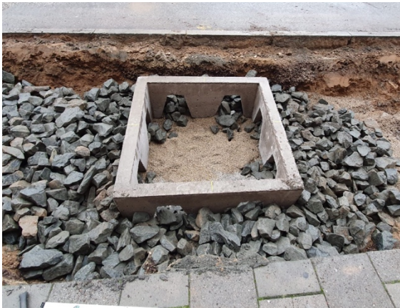
Figur 6. Trädgropsfundament i betong (något beskuren). (Nässlander, u.å.-b)
