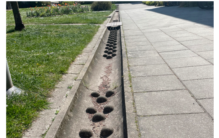
Figur 17: Dagvattenkanal i Augustenborg, Malmö. Eget foto.
