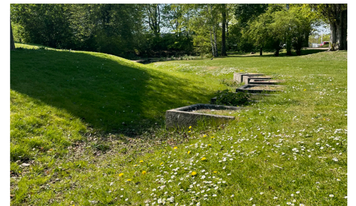
Figur 18: Svackdike i Augustenborg, Malmö. Eget foto.
