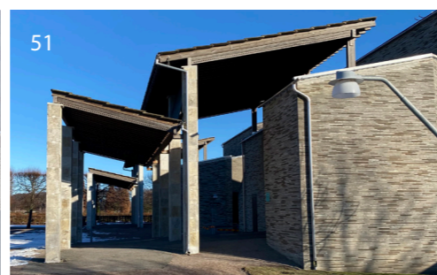
51. Pelartak vid s:t Knut och s:t Gertruds kapell. Bild tagen från sidan, där det syns hur taket lutar i olika vinklar, vilket skapar ett spännande formspråk.
