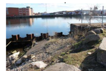
Avsats med stålfundament för exempelvis framtida brygga.
