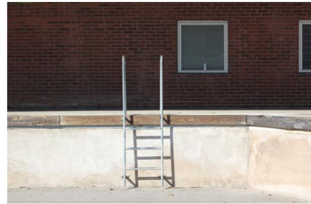
48/ Metaller av olika slag. Trappor och gallerdurkar. Stängsel. Korrigerad plåt, ofta med patina.
