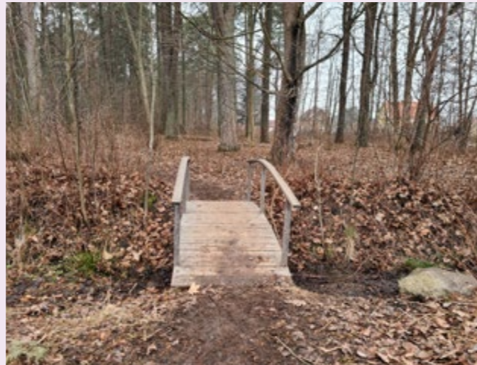
Figur 20: Bro över dike till anslutande skog.
