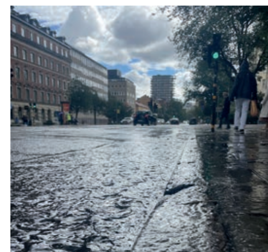
Stående vatten efter skyfall, övergångsställe över Ringvägen vid korsningen med Hornsgatan. Tänk om det hade kunnat bevattna träden i stället...
