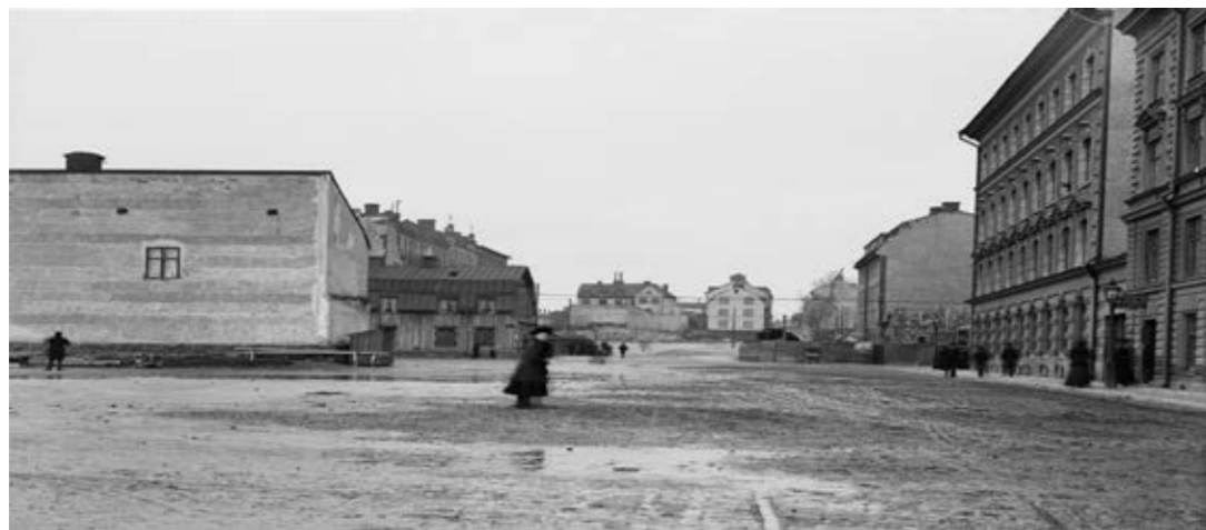
Bilden visar hur Ringvägen var en väg med stampad jord som ytbeläggning. Samtliga trafikanter fick samsas på samma väg. Ringvägen norrut från Krukmakargatan mot Hornsgatan, därefter Yttersta Tvärgränd norrut. 1894–1912
