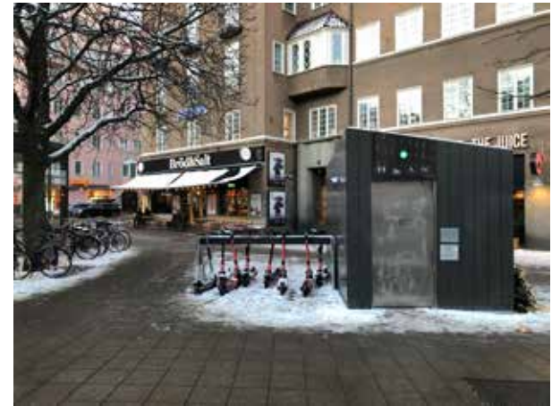
Fig 51. Toalettbyggnaden och sparkcykelparkeringen med caféverksamhet och uteservering i bakgrunden.
