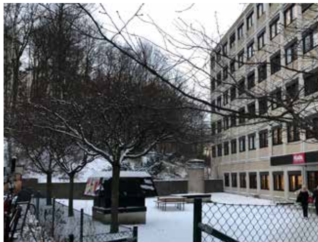
Fig 32. Vy från gången över det norra punkhusets gröna baksida.
