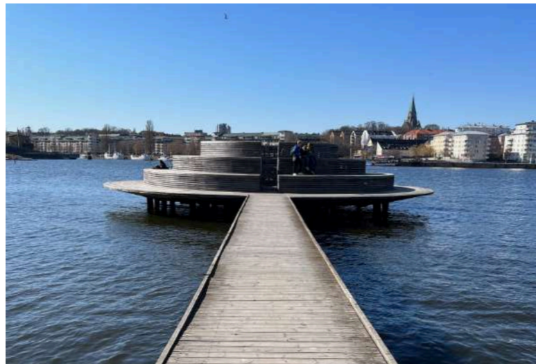
Figur 61. Vinden följer den runda formen på utsidan och fördelar sig jämnt runtom.
