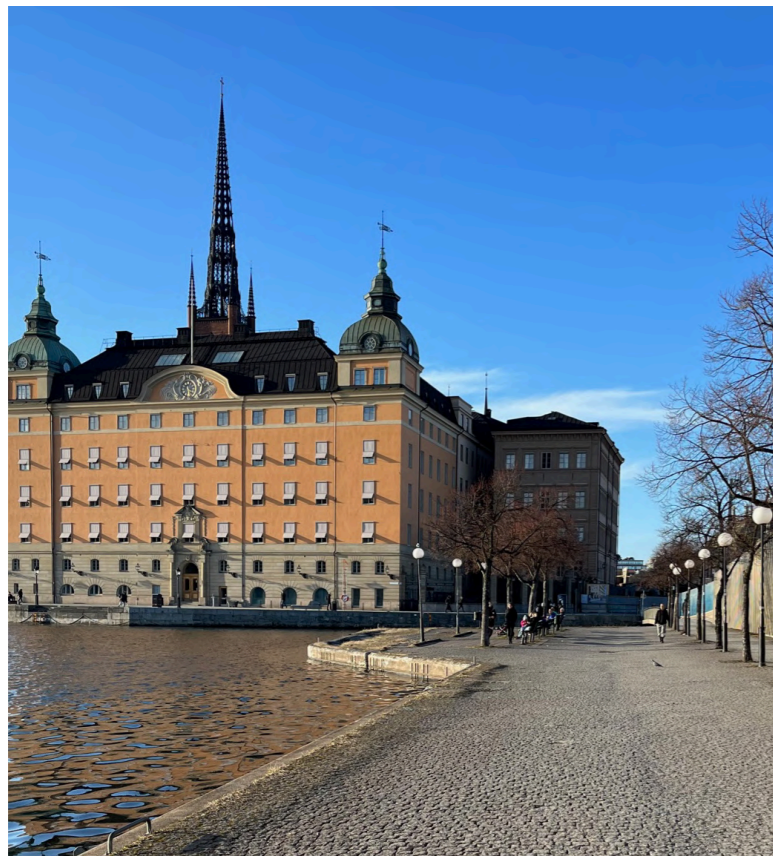
Figur 87: Munkbrohamnens nordvästra del där kajen breddas och ger plats åt vistelsezoner med bänkar och belysning.
