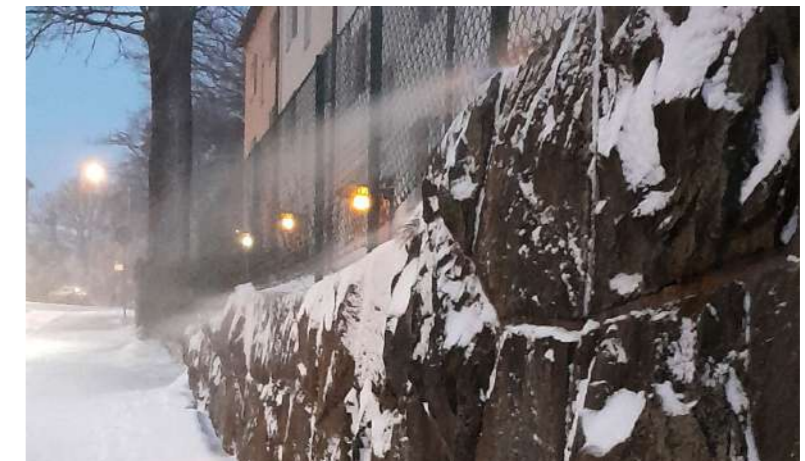
Figur 39: Vinden tar fart över murkrönet och sveper med sig snön på sin väg. Murens ojämnheter skapar små fickor där vinden inte kan leta sig in och där snön stannar kvar.
