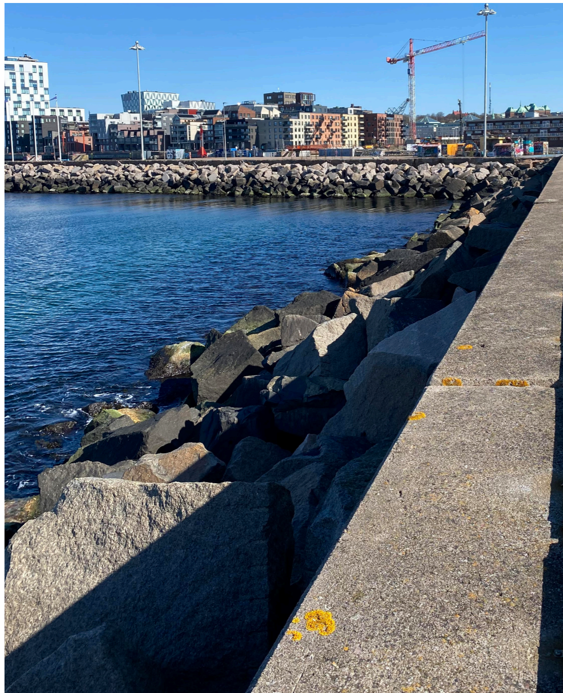
Figur 32: Stenskoningen vid området som kommer att bli Atlantparken.
