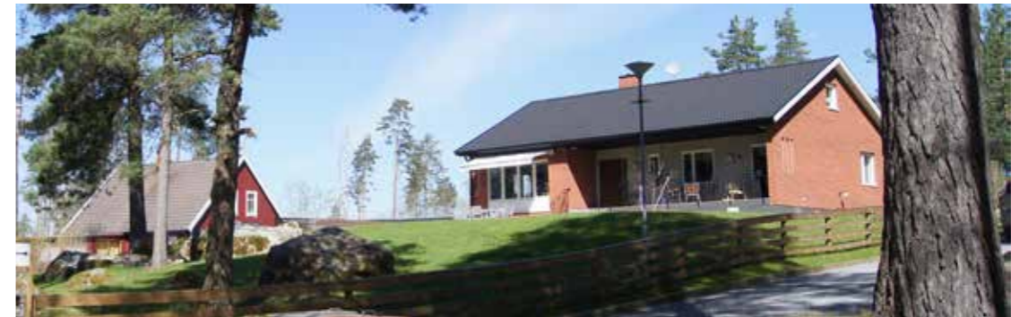
Figur 42. Eftersomden nyare bebyggelsen inte ligger i direkt anslutning till den äldre bebyggelsen i kyrkbyn så inkräktar den inte på den äldre karaktären. Fotot är taget 2018-05-05.
