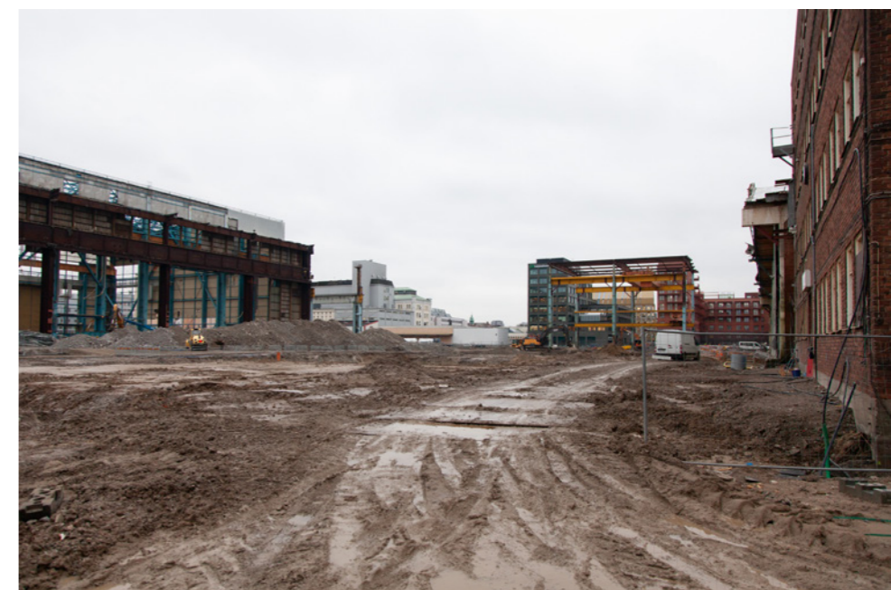
Ett lerigt projektområde som kantas av byggnader, varav vissa är på väg att rivas.
