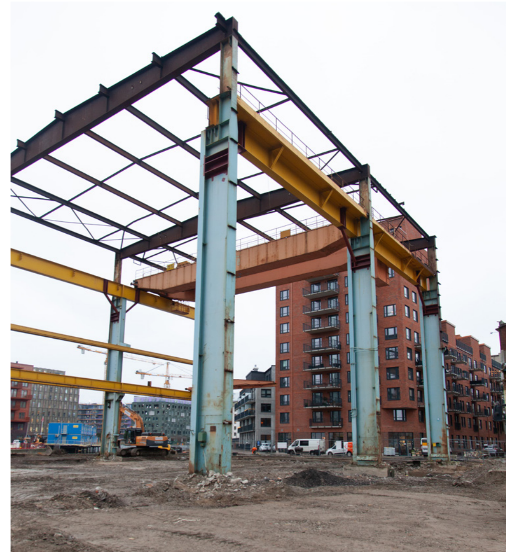
Traversen är en bevarad lyftkran från en av de gamla hallarna som rivits och som måste integreras i parken på något sätt.
