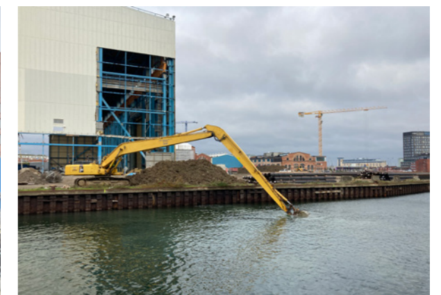
Arbetet med att fylla upp bassängen från elva till fyra meters djup hade redan påbörjats.
