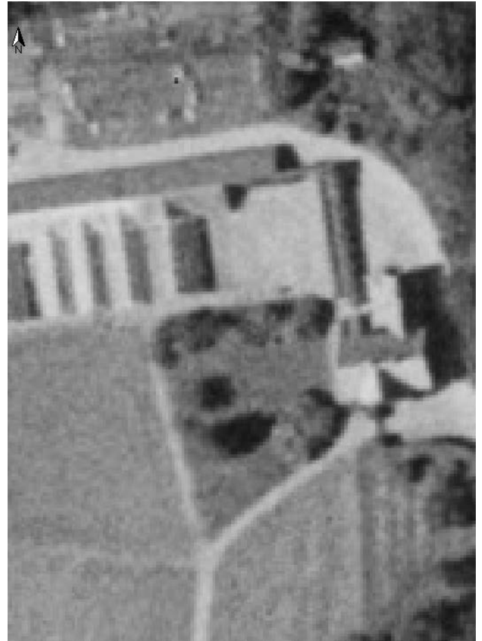
Fig 77. Flygfoto med fokus på trädgårdsmästarebostaden och häcken runt om från 1975. Denna del är utsett som "förvaltarens trädgård" men följer det formspråk och organisering som var kopplat till trädgården. (Lantmäteriet 1975)
