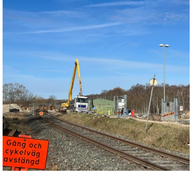
Figur 12. Del av Hammarlundsvallen och Pyntens pumpstation. (foto: författare). Bilden visar pågående bygget vid Hammarlundsvallen och Pyntens pumpstation.
