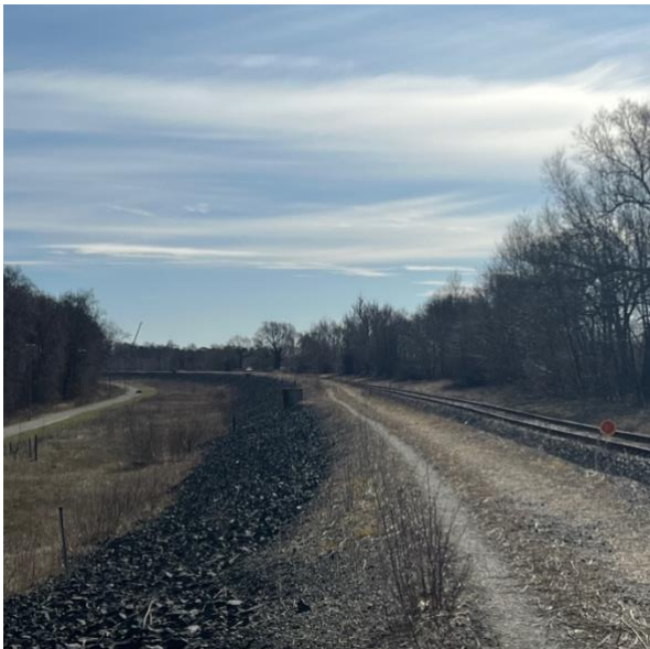
Figur 15. Del av Hammarlundsvallen. (foto: författare). Bilden visar två av tre parallella skyddsvallar längs med Hammarsjön, med gång- och cykelväg ovanpå vänstra vallen och järnvägsspår ovanpå högra vallen.
