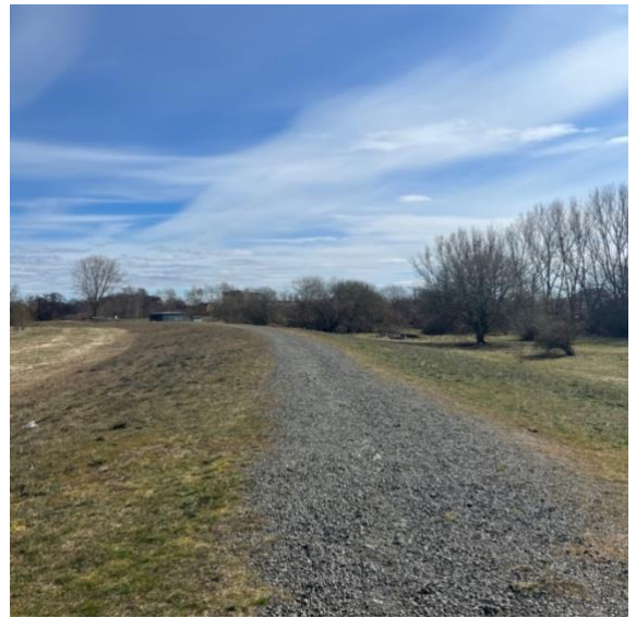
Figur 8. Del av östra vallen. (foto: författare). Bilden visar skyddsvallens krön med en gångväg och möjlig körväg för arbetsfordon.
