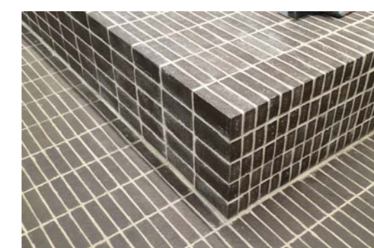
Tegelmur i stapelförband
