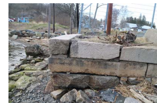
Mur av borgmästarsten rustas upp
