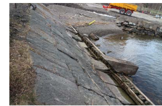
Befintlig glacismur sparas och rustas upp
