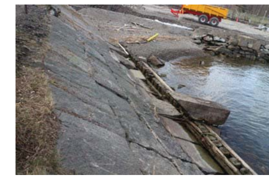
Befintlig glacismur sparas och rustas upp
