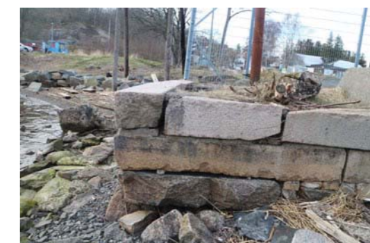
Mur av borgmästarsten rustas upp
