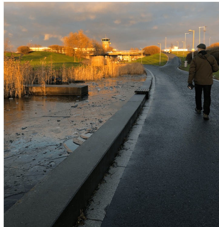
Figur 17. Nansenparkens vattenkanal. Vatten pumpas upp till tärnplassen (ligger vid föredetta flygtornet bortest i bild) från Centraldammen och rinner tillbaka till dammen via vattenkanalen. Foto: Nina Littman
