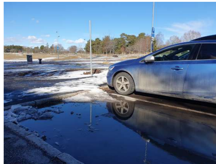
Figur 35. Punkt där vatten kan ledas in i parken. Fotot är taget i slutet på Solskengsgatan. [2023-03-15]
