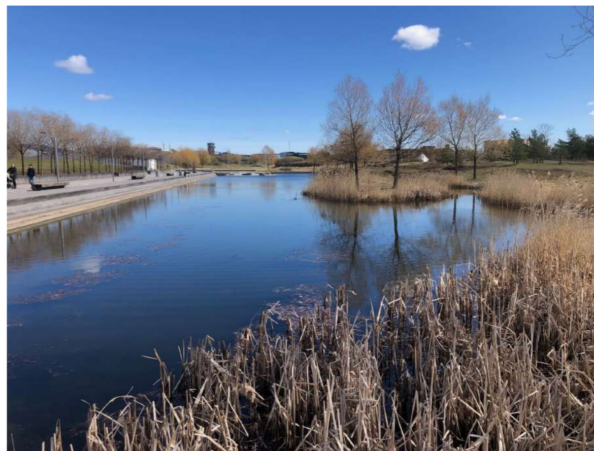
Figur 16. Fotografi över Centraldammen. Dammkanten har en skarp övergång mot bryggan och en mjuk övergång mot naturmarken. Fotografiet taget från dammens utlopp mot norr. Foto: Lars Johansson [2023-05-03]
