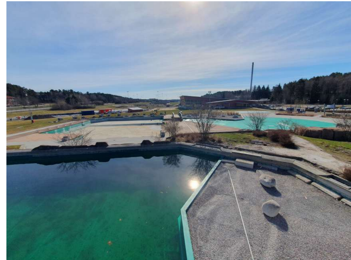
Figur 21. Fotografi över Midgårdsbadet från hopptornet. I den djupa poolen är vattnet kvar över vintern, medan det töms i lek och simbassängen. I anslutning till hoppoolen ligger reningsbädd D. [2023-04-20]
