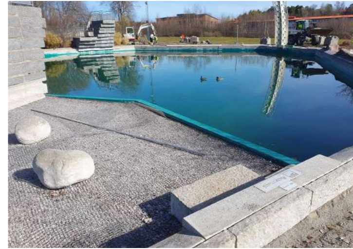
Figur 7. Badzonen med klart vatten. I framkant syns en reningszon som är under renovering. [2023-04-20]
