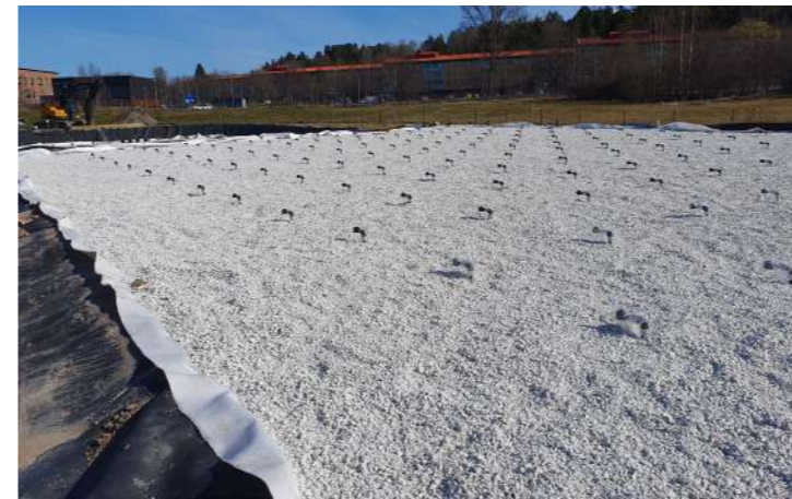
Figur 8. Reningszon, ex situ , på Midgårdsbadet, Märsta. Sprinklarna sprutar upp vatten som sedan perkolerar genom gruset. [2023-04-20]
