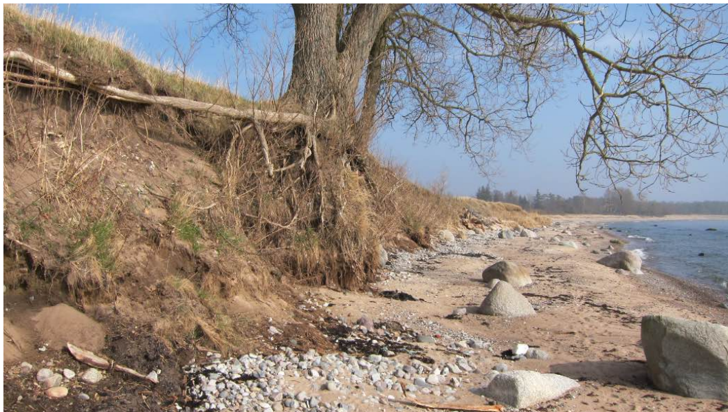
Figur 28. Erosion längs Ystadkusten. Ystads kust är hårt ansatt av erosion. I bild syns Löderups strandbad, som är särskilt hårt drabbat (Region Skåne, 2019).
