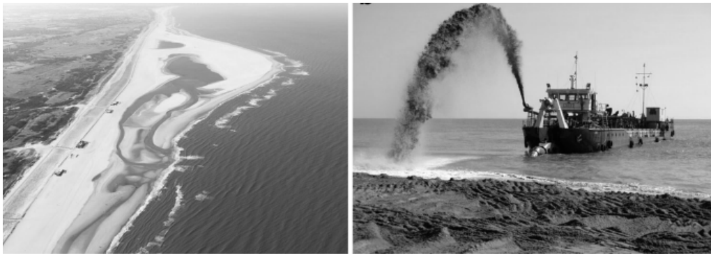
Figur 9. Strandsköning. Ovan syns en, av erosion hårt ansatt, strand där strandfodring har bedrivits från strandens spets. (Pranzini et.al., 2015, s.453)
