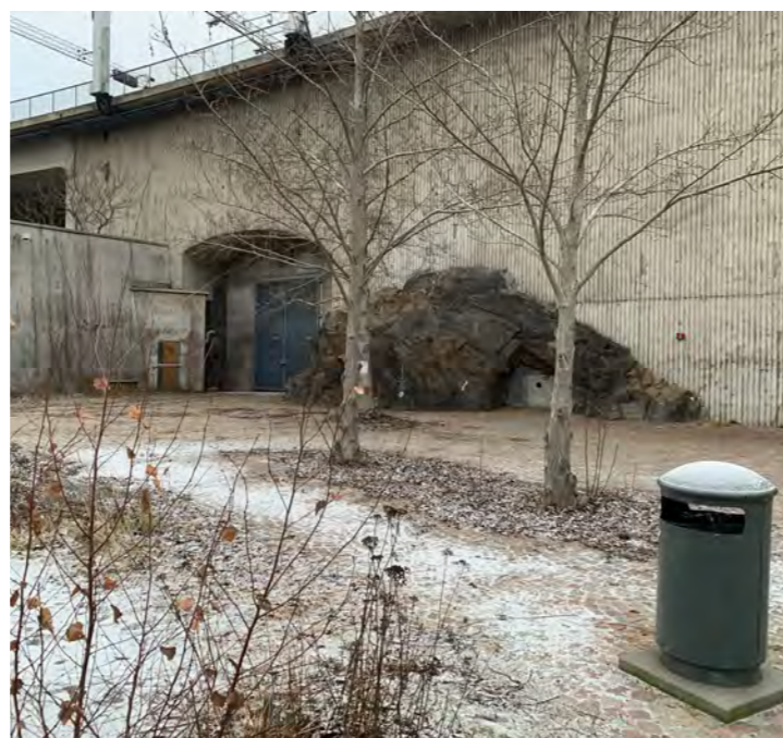
10. Figur 38. Ytan närmast Danviksbron är övervuxen av sly, känns otrygg och ej omhändertagen.
