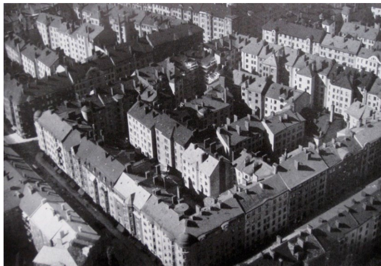
Figur 2. Kv. Eldaren, Stockholm. Kvarter med tät gårdsbebyggelse. Byggnadsår 1902-1903. fotograf okänd, 1940-tal.
