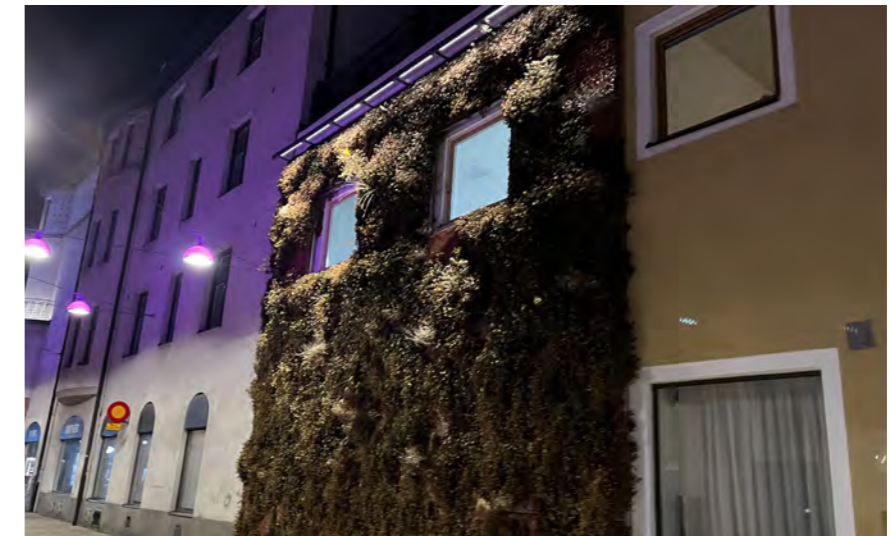
Figur 67 - Växtväggen är utrustad med extra belysning som fungerar i samspel med övrig belysning. Växtväggen syns bra även på natten och ger stark prägel på platsen.
