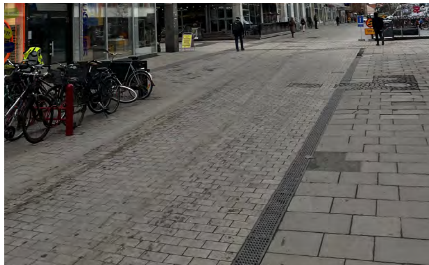
Figur 24 - Slitage och smuts i markbeläggningen.
