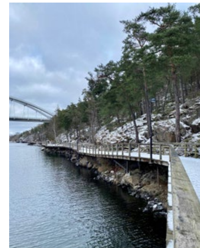
Figur 95. Konsolbrygga som upplevs lätt och anpassad till landskapet. Minskar påfrestning på havsbotten.
