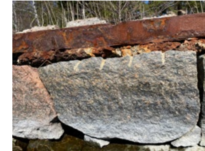
Figur 48. Konstruktionen av en äldre militär brygga utgörs av en stenkista med fästen i järn och en betongyta ovanpå. Uppmuntras att restaureras enligt Antikvarie Wilund (2019).
