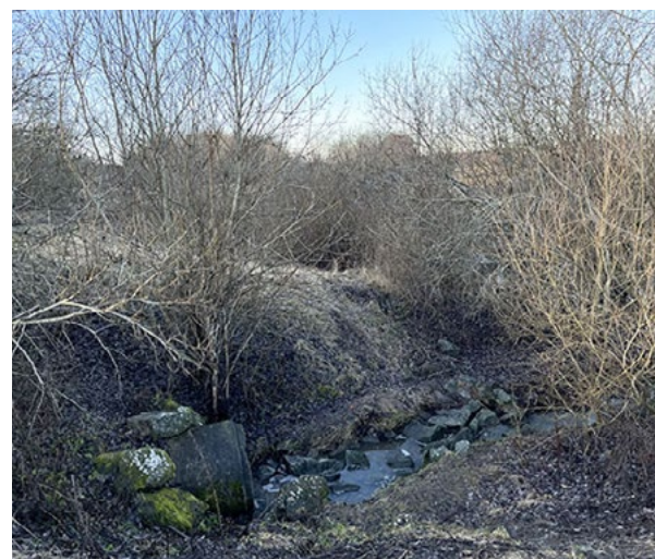
Figur 52. Fotopunkt 3A. Karaktärsområde 3, bäcken, där inloppet av dagvatten från nordöstra Eriksberg är placerat. Inloppet är ordentligt nedsänkt i förhållande till intilliggande mark och har branta slänter. Här börjar den anlagda bäcken. 2023-01-26.
