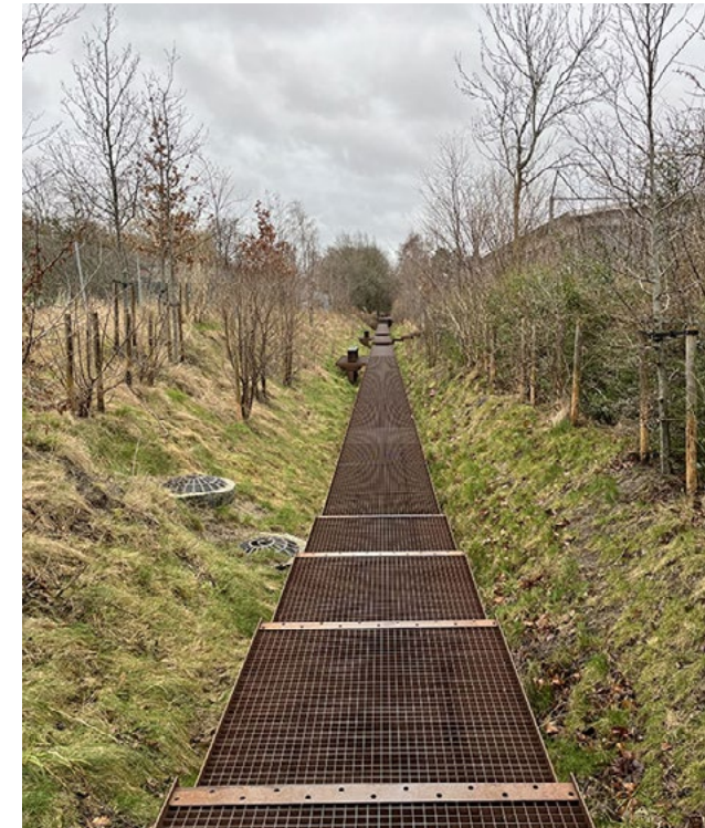
Figur 33. Den upphöjda spången gör att vatten kan samlas i diket utan att det påverkar framkomligheten. 2023-02-20.
