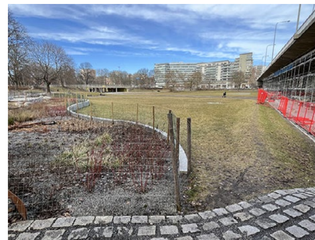
Figur 28. Vy mot gräsmattan dit vattnet vid större regn svämmar över från regnbädden. Notera höjdryggen mot bron till höger som stänger in vattnet. Dessa vallar finns även på andra sidan bron. 2023-03-23.
