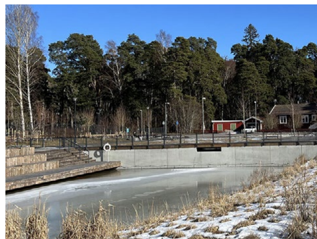
Figur 14. Genom en öppning i muren under trädäcket mellan regndammen och parkdelen kan vattnet brädda över från dammen. 2023-03-16.
