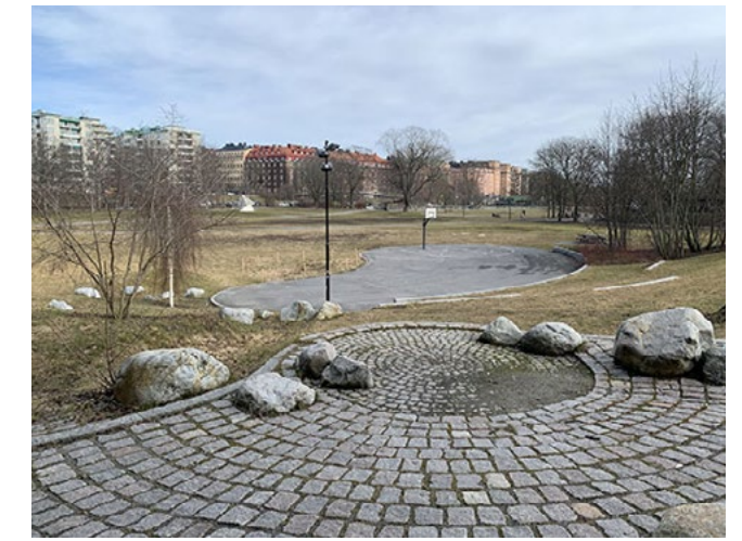
Figur 27. Vy mot bollplanen som också fungerar som översvämningssyta för dagvatten. Cirkeln i förgrunden är nedsänkt och fungerar som ett vattenstråg där dagvattnet först samlas och synliggörs innan det rinner ned till bollplanen via ett svackdike. 2023-03-23.
