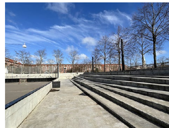
Figur 41. Den nedsänkta bollplanen omges av höga trappor. Integrerat i dessa finns ramper som gör ytan tillgänglig för alla. 2023-02-21.
