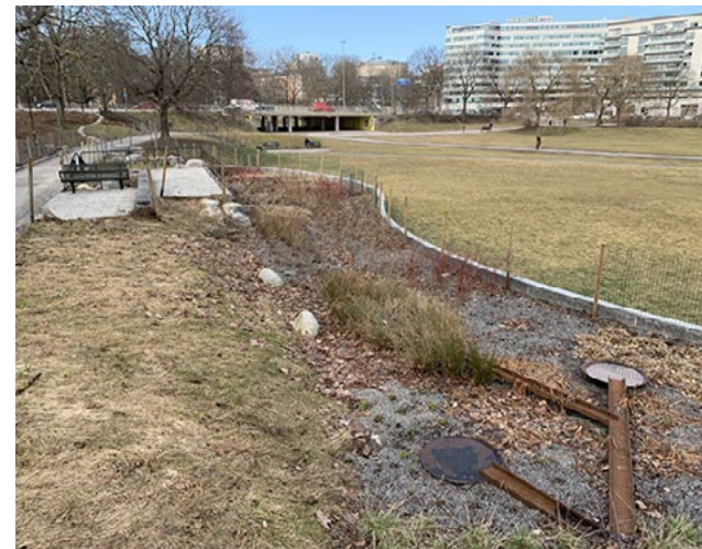
Figur 25. Dagvatten leds till regnbädden via kanaler, bland annat den i cortenstål i nedre högra hörnet. Vid större regn bräddar vattnet över kanten till gräsmattan till höger. 2023-03-23.
