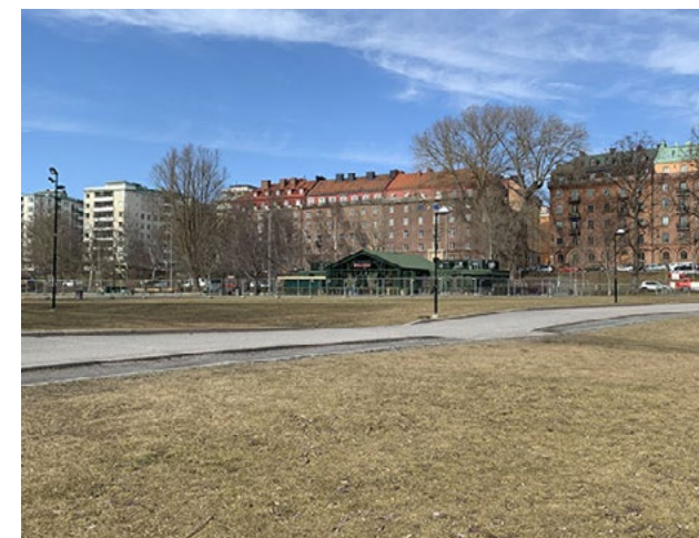
Figur 29. Den centrala delen av gräsmattan är nedsänkt och leder vattnet mot utloppet och recipienten. Gångvägen och kantstenarna har sänkts för att underlätta vattnets väg mot Riddarfjärden. 2023-03-23.
