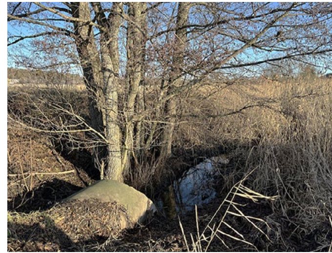
Figur 76. Fotopunkt 9B. Utloppet från Ekebydalen går via en ledning under Ekebydalsvägen till Hågaån. 2023-01-26.
