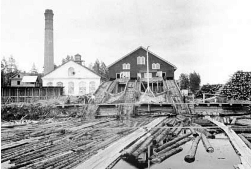
Figur 19. Kovdasågen från havssidan. Till vänster syns pannhuset och till höger såghuset. Foto: Västernorrlands museum (u.å.)
