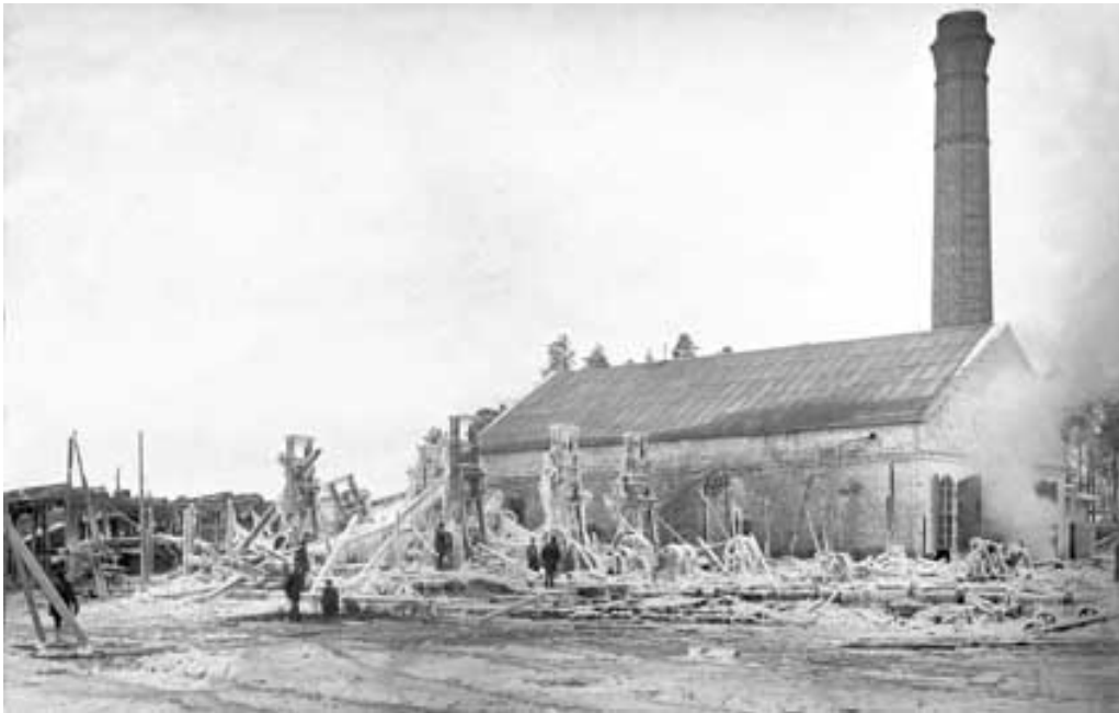
Figur 29. Nedbrunnen såg i Kovda 1914. Foto: Västernorrlands museum (u. å.) . Byggmästare Söderlund från Alnö fick återvända för att bygga upp den nya sågen (Jonsson 1981).
