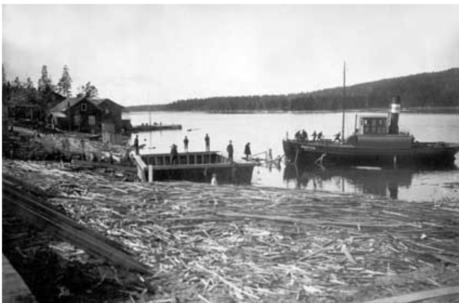
För att utöka brädgårdsområdet fyllde man ut mellanliggande sund med ribb. Det var vanligt kvinnoarbete vid sågen. Båten "Sarpin" är byggd i Norge (Jonsson 1981).
