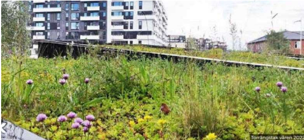
Figur 9. Torrängstak (Veg Tech 2022)
