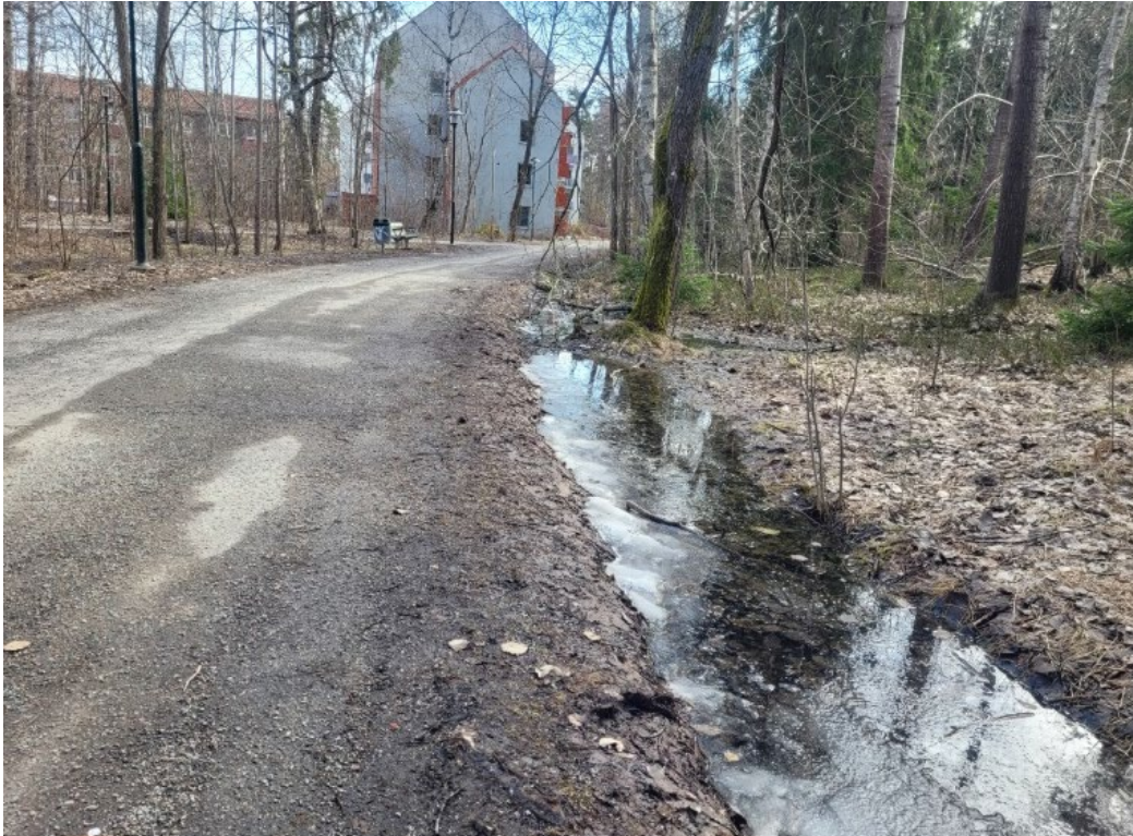
Figur 8. Stående vatten längs vägen. Projekt- SHP 2023.
