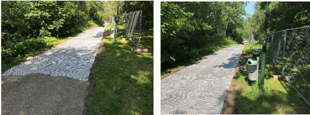
Figur 12. Bilder från Ölmevägen och anläggning av Geonät. (Ekman 2021).
