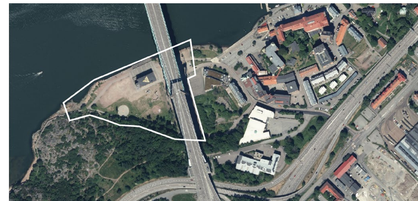
Figur 26. Nutida flygfoto av platsen som visar pågående exploatering vid vagnhallarna samt tillkomst av byggnader vid Klippan. Skala 1:5000. Ortofoto, 1 m färg © Lantmäteriet
