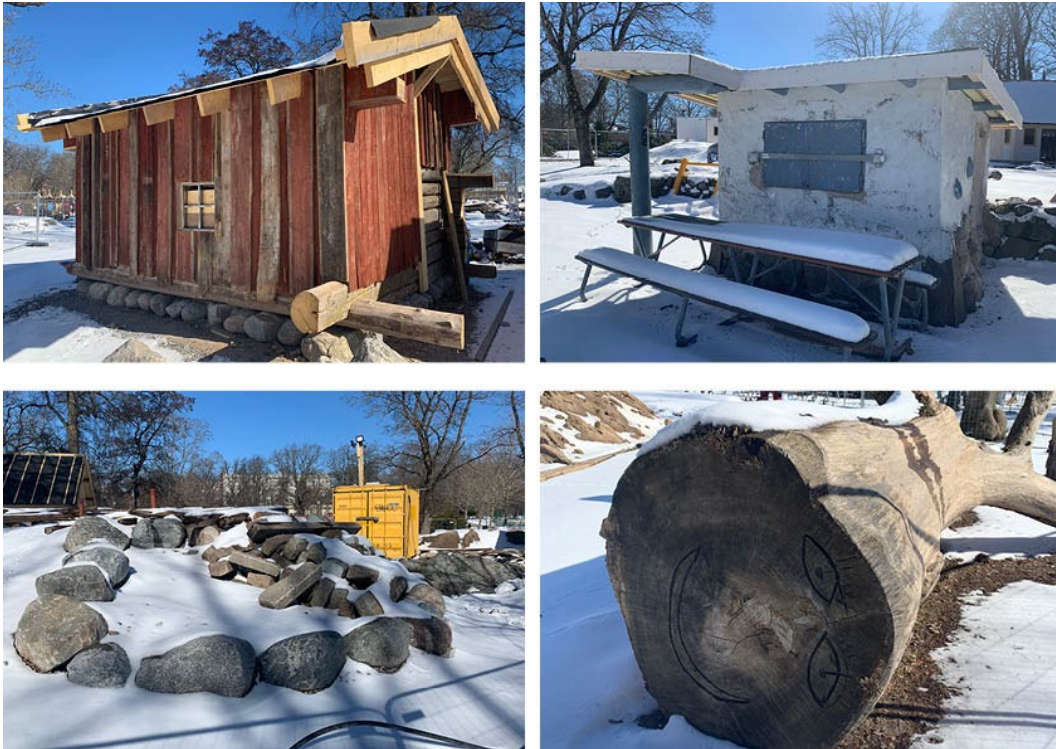
Figur 16. Stadsparkens lekplats under byggnation.
