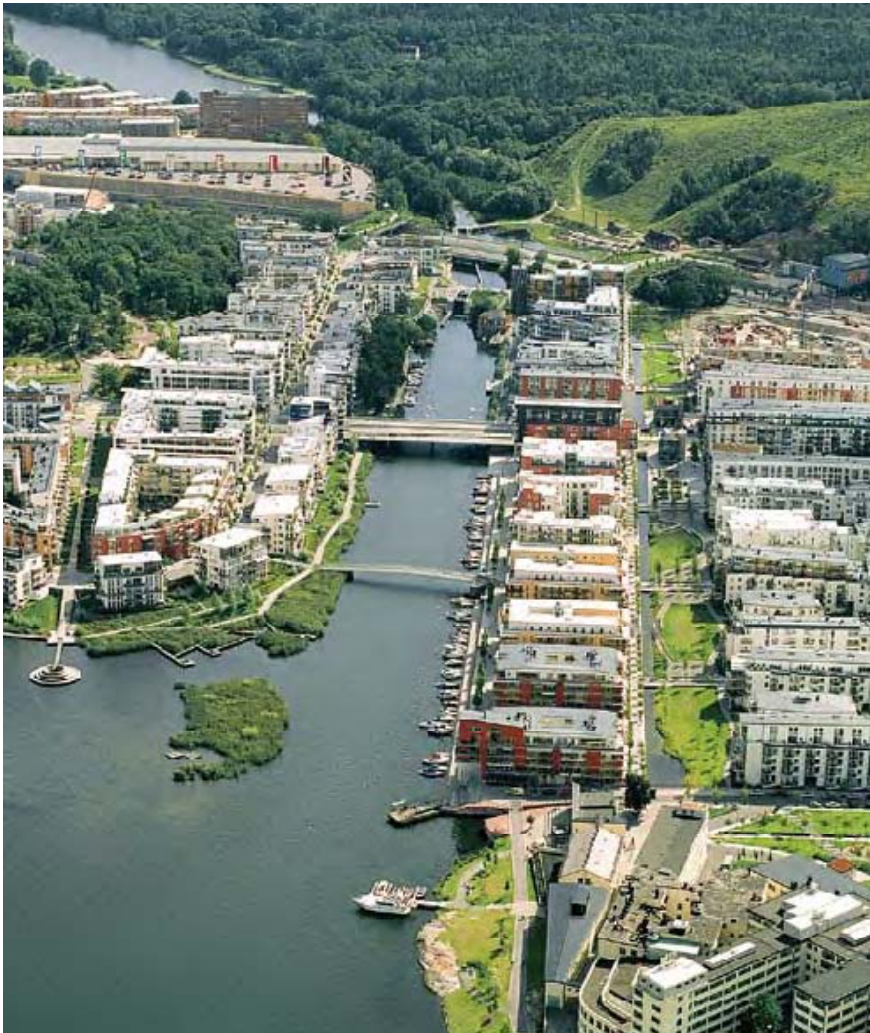
Bild 2. Mitt i bilden syns Sickla kanal och till höger om denna ligger Sjöstadsparterren med dagvattenkanalen.(Foto: Lennart Johansson, ur Finnson 2006 s. 9).
