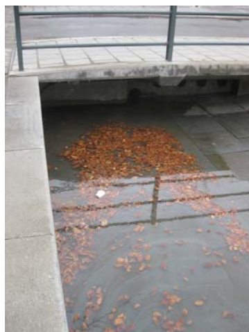
Bild 11. Vattnet rör sig genom rör under broarna vilket gör att vattnets flöde i kanalen reduceras.
