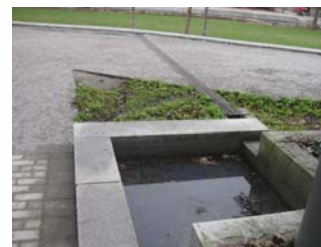
Bild 9. Fördröjning av dagvattnet mellan en bostadsgård och Sjöstadsparterren. När vattnet fyllts upp i den lilla dammen rinner det vidare till kanalen.
