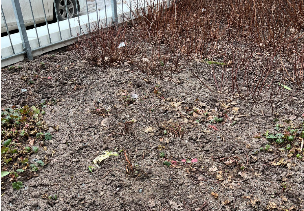
Figur 11. Det finns utmaningar med att anlägga rabatter på bjälklag. Här syns en omplantering efter vattenläcka. (Foto: Emma Norlén)
