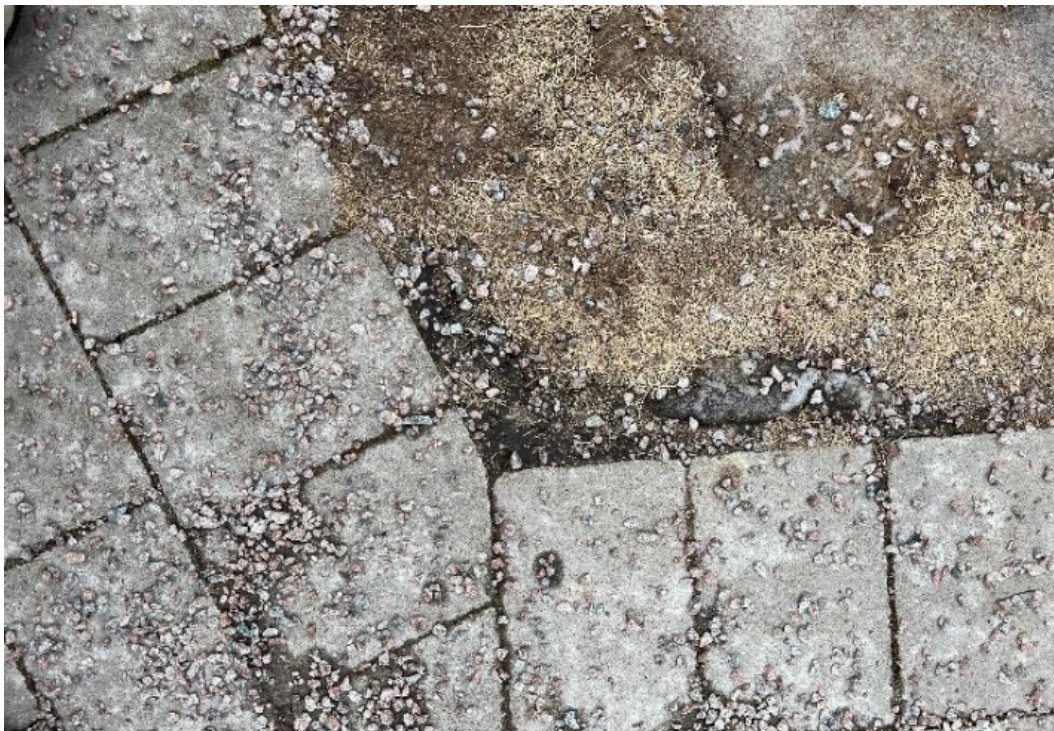
Figur 5. Med uteblivet kantstöd går det åt mycket sandningsgrus och gräsmattan tar skada. (Foto: Emma Norlén)
