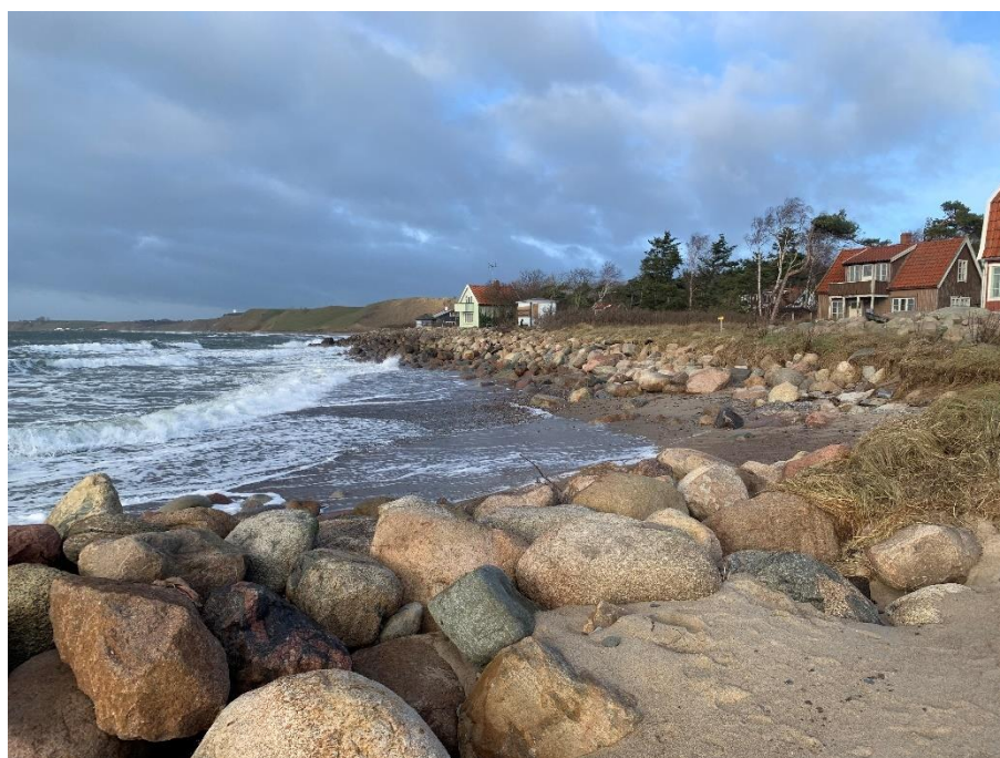
Bild 2: Visar på hur stenskoning placerats ut i Löderup strandbad.
