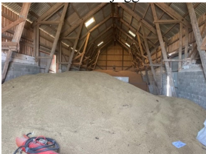
Figur 5: Spannmålslager i ekonomibygnad. (C. Gillerstrand 2022)
