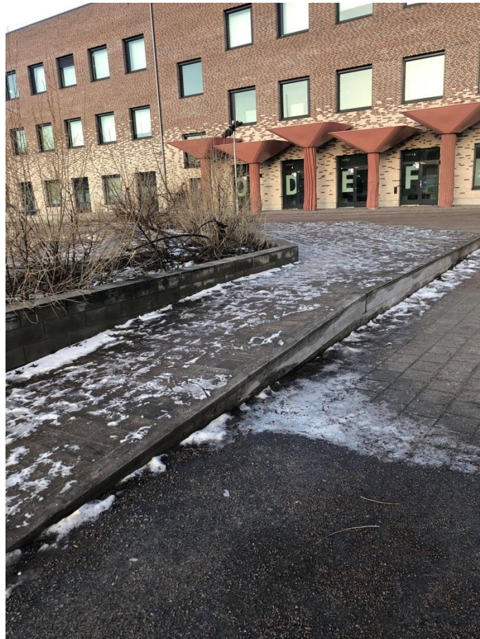
Figur 13. Tillgänglighetsanpassning i form av en ramp upp på ett trädäck. I bakgrunden syns svampliknande installationer vid skolans entréer. Foto: Ylva Ledberg
