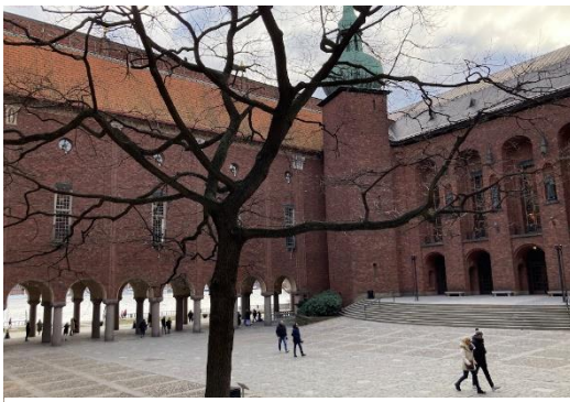
Figur 4. Fotografi (Ståhl 2023) från Borgargårdens nordöstra hörn. Den rundade trappan till festentrén syns till höger i bilden, med rododendronplanteringen till vänster. Rutnätsmönstret i markbeläggningen med kullersten inramad av större gatsten syns i förgrunden till vänster.
