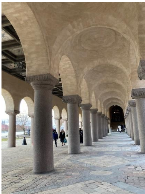
Figur 6. Fotografi (Ståhl 2023) av pelargångarna i Södra Portiken. Marmortrappan är belägen längst bort i bilden, i Södra Portikens nordvästra hörn. Pelargången närmast Borgargården avslutas med ljusst putsade kryssvalv i taket.
