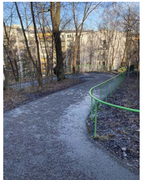
Figur 8. Exempel på en svårtillgänglig sträcka. Trots stråkets serpentinform är längslutningen cirka 10%.
