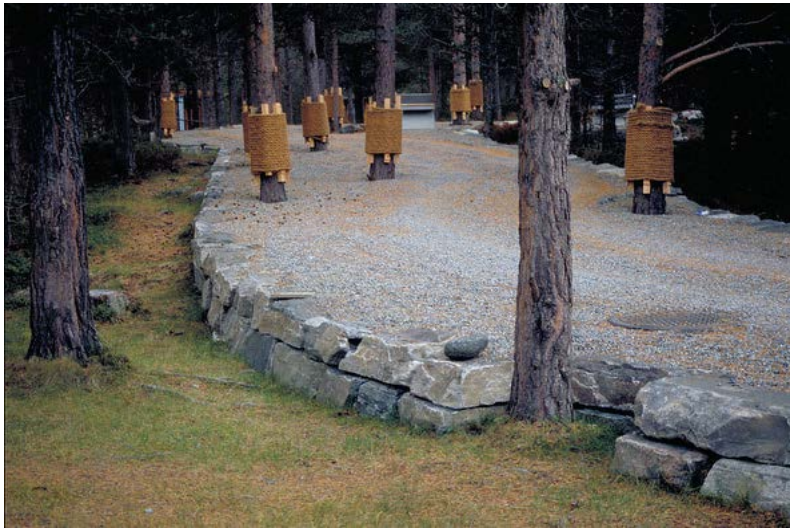
Figur 50. Andra delar av platsen består av grusytor som höjts upp med hjälp av stödmurar i råkilad grå natursten (Landezine 2010). Bilden visar också på hur mötet med träd har hanterats på platsen. De träden som står i mitten av vägen har byggts in i grusytan och försetts med ett skydd från bilarna (ibid.) medan träd vid kanten istället kan byggas runt. Oavsett hur väl träden klarar av att stå i grusytan borde det, för att försäkra sig om trädets långsiktiga vitalitet, antagligen ses som ett sista alternativ när det inte är möjligt att istället dra stråket runt träden. Copyright: Jensen & Skodvin.
