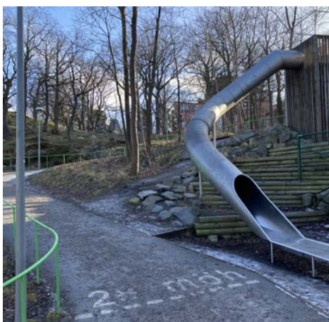
Figur 9. Makadam skyddar mot slitage i lekmiljöer. Efter att ha krasat lite på ytan av bark och förna visar sig det pålagda bärlagret.
