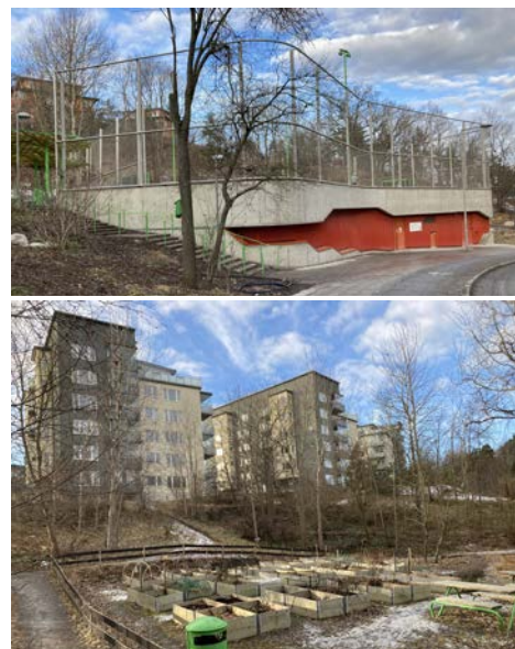
Figur 11. Fotbollsplanerna i Årstabergsparken är små och riskerar att bollar flyger ner för slänten. En av planerna har möjliggjorts genom att den lagts på taken av ett teknikhus (översta bilden). Odling är en annan aktivitet som kan anses passa bättre i mer låglänt terräng. Här har knapp yta och tunn jordmån reducerat odlandet till enstaka pallkragar med påförd jord.
