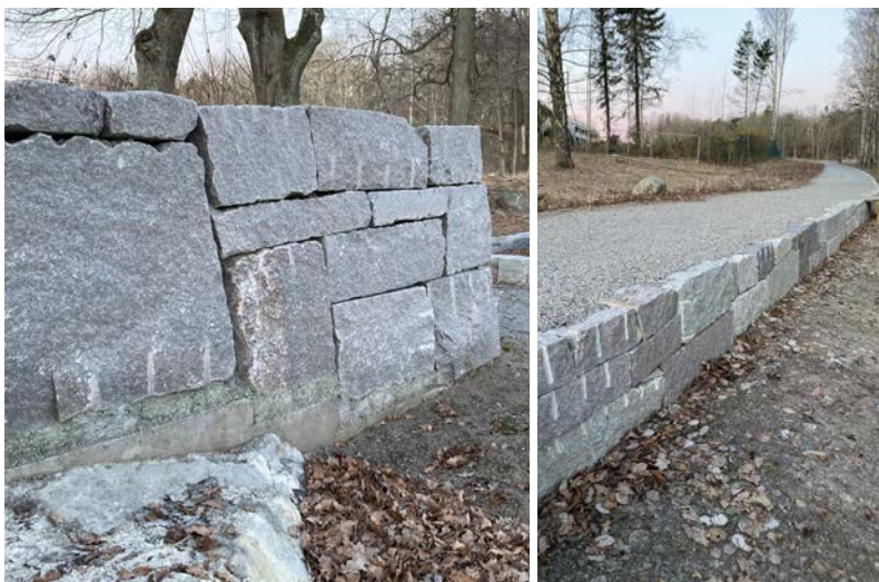
Figur 51. Inspirationsbilder på stödmurar som liknar de i Liasanden i stil och funktion men från ett annat projekt: Klockelund av Land Arkitektur (u.å.). De råkilade stenarna har passats ihop i en enhetlig och stabil konstruktion samtidigt som de har ett naturligt uttryck i sin gråa färg och lite oregelbundna form. Murarna är till synes kallmurade men stenarna har fixerats med bruk en bit in i fogen. Där muren går över berg i dagen står den på en utjämnande betongsula (vänstra bilden). En stödmur av denna typ kan anses ha hög potential att passa in på Talludden där berg i dagen liksom blockig terräng är vanligt.
