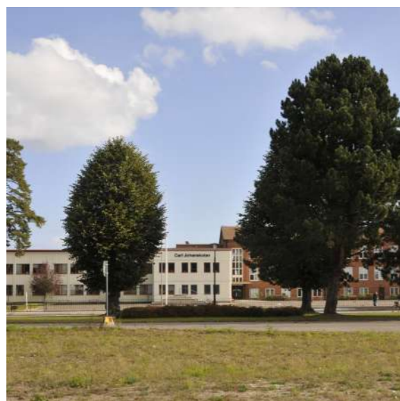
Figur 43. Carl Johanskolan på östra sidan av väg 49.
