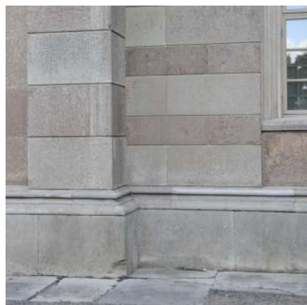
Figur 78. Slutvärnets fasad på fästningen i kalksten.
