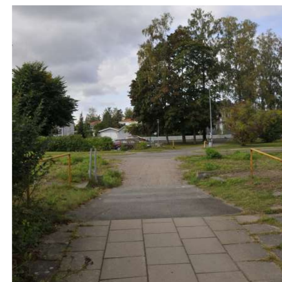
Figur 73. Betongplattor och asfalt på tvärpasset i anslutning till stationen.
