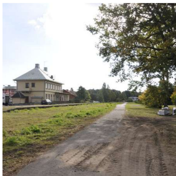
Figur 74. Gångvägen på bangården är av sliten asfalt.
