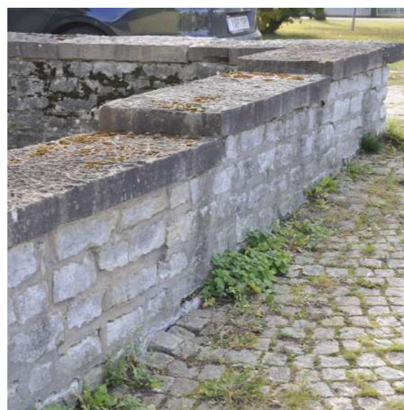
Figur 71. Kalkstensmur vid den gamla järnvägsstationen.
