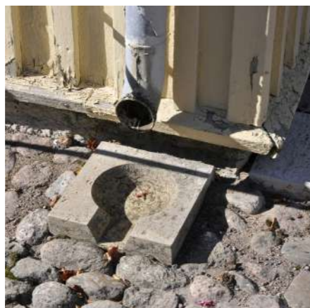
Figur 79. Detalj i kalksten på fästningen.
