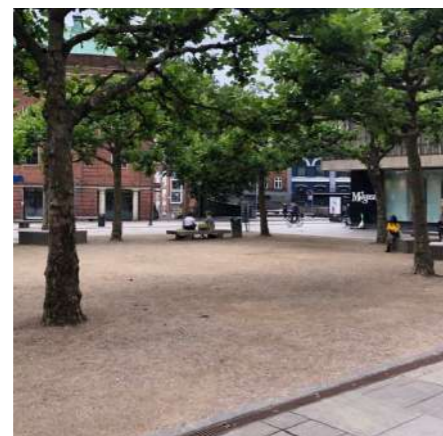
Figur 131. Markbeläggnen runt konsthallen består av stenmjöl. Foto: Platanhaven, Odense.
