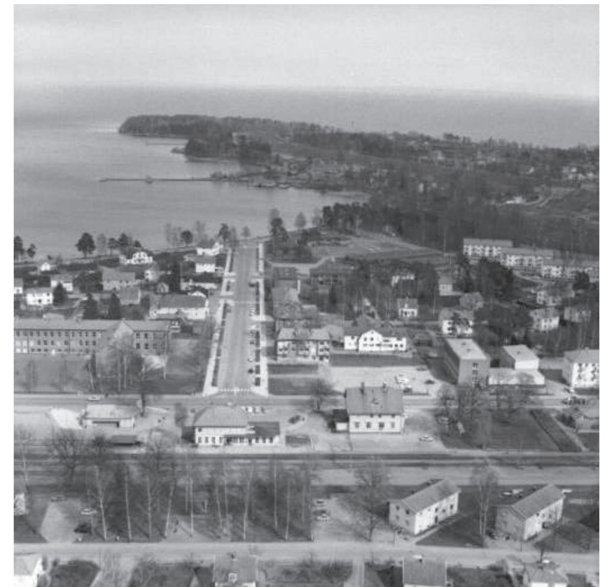
Figur 16. Flygfoto över Karlsborg från 1973. I mitten syns järnvägsstationen och Kungsgatan som går från Vättern, udden i bakgrunden är fästningen. Foto: Anders Åkerberg, Karlsborgs fästningsmuseum.
