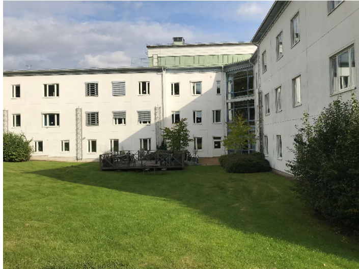
Figur 32: Bild på det befintliga trädäcket utanför personaldelen, p-vinkelgården. Bakom däcket ser man kronan på en av katsurorna som är planterade här. Observera den svaga lutningen som skapar en offentlig känsla utan interaktion med passerande.
