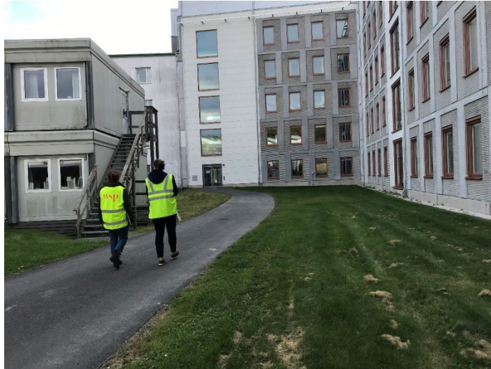
Figur 30: Bild på gångväg till den nybyggda delen. Till vänster ser man en av de tillfälliga paviljongerna. Ingång för personal finns i änden av den asfalterade vägen.
