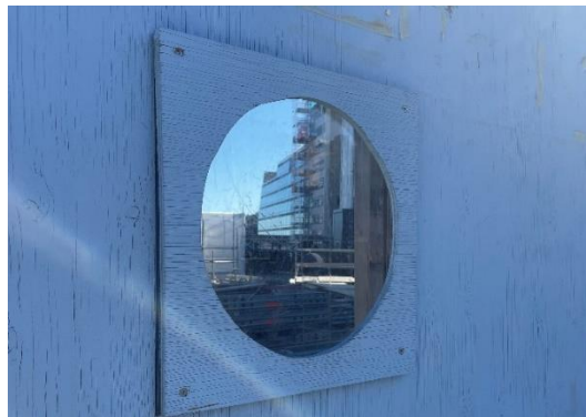
Figur 26 Byggplanket runt Slussenbygget har blåmållats. Fönster och barnluggar har satts upp på lämpliga ställen (Stockholm stad, 2022a).
