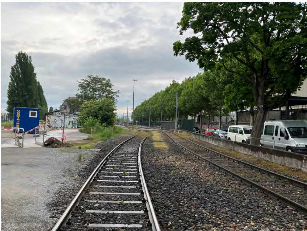
Figur 34. Fotografi över befintlig situation, riktning norrut över spårområdet.
