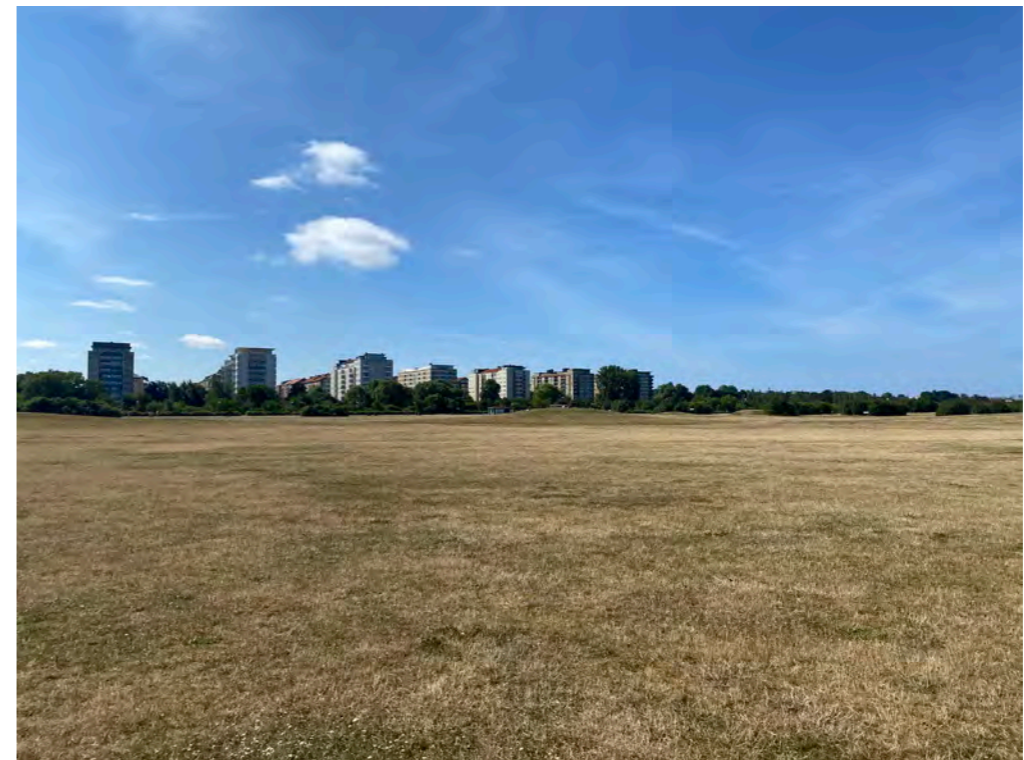
Figur 24: I bakgrunden syns den tidstypiska arkitekturen från mitten av 1900-talet som möter det stora grönområdet på Ribersborgsstranden. Foto: Frida Westberg Ekerljung 2022-07-24
