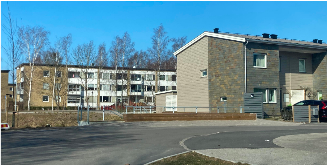
Bild 2: Nybyggda boklok-radhus intill lägenhetshus från miljonprogrammet i Karlslund, Landskrona (Författarens bild, 2022).
